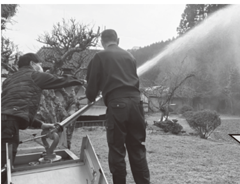
▲ 防火設備のうち「放水銃」と呼ばれる設備の点検の様子
