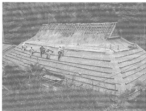
▲屋根茅の葺替え作業が進む永沼家住宅(21年5月)
