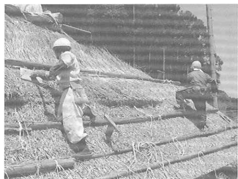
▲葺替えを行う葺師さんたち。急勾配の屋根を上下します
