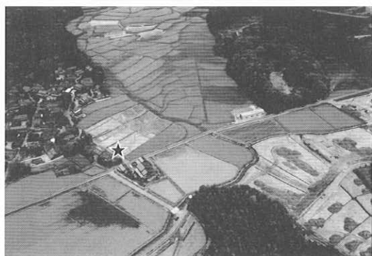
▲上空からみた池田地区。★印が木樋出土地点
