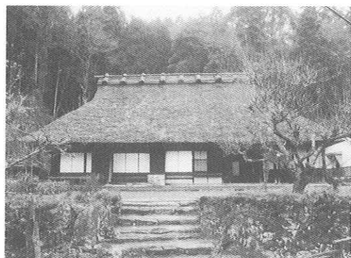
▶国指定重要文化財 永沼家住宅
